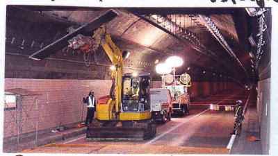
月山トンネル天井板工事の様子
